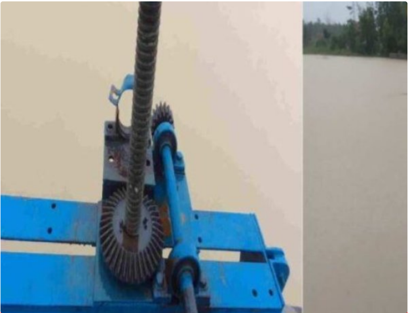
Pintu air Albaret Simpang Mesuji
